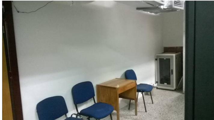
Foto 3: Pared parte Interior
