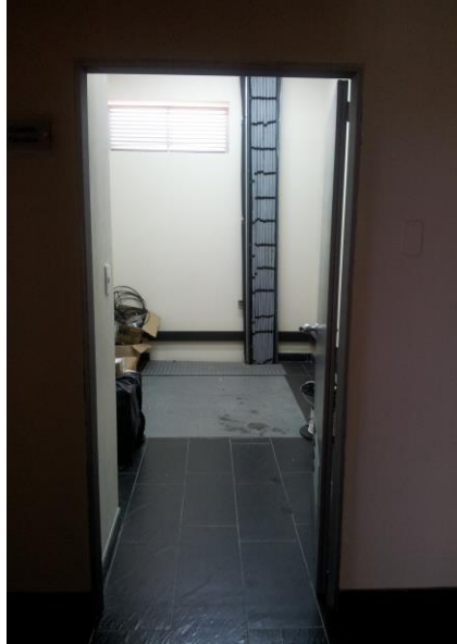
Foto 9: Entrada Cuarto Técnico Vista Exterior
