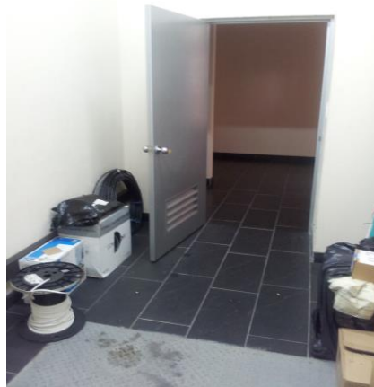
Foto 10: Entrada Cuarto Técnico Vista Interior
