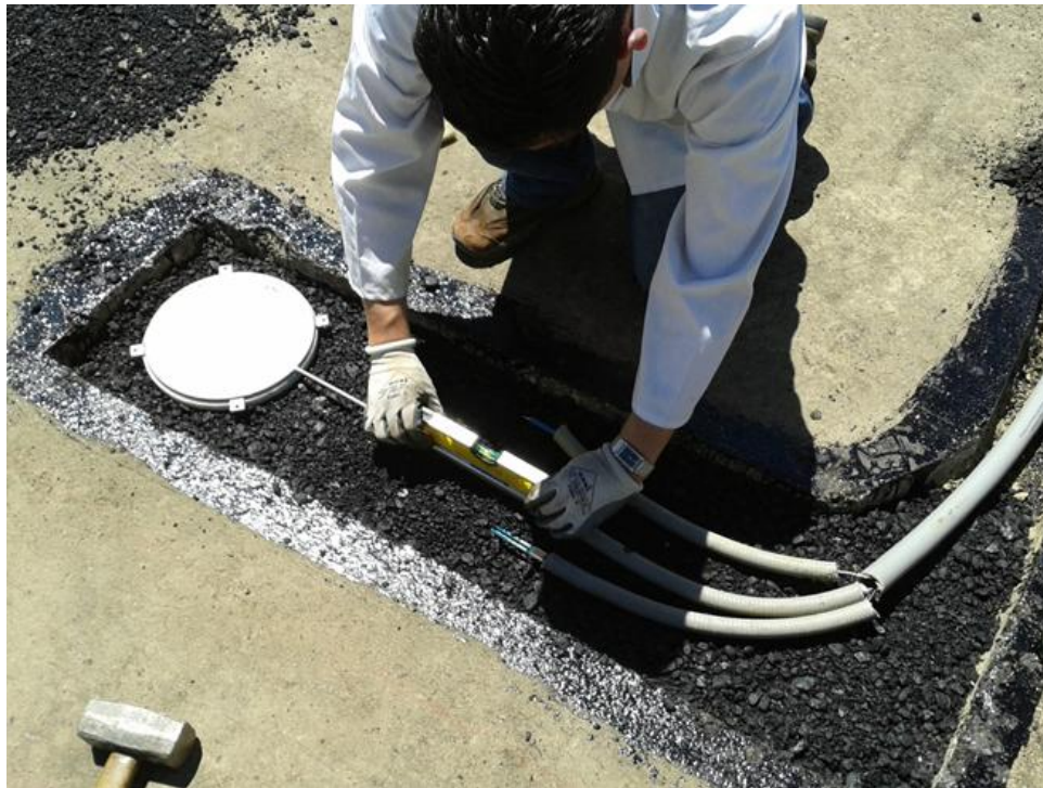
Figura 21. Fotografía de una construcción de una vía instrumentada en la UMNG
