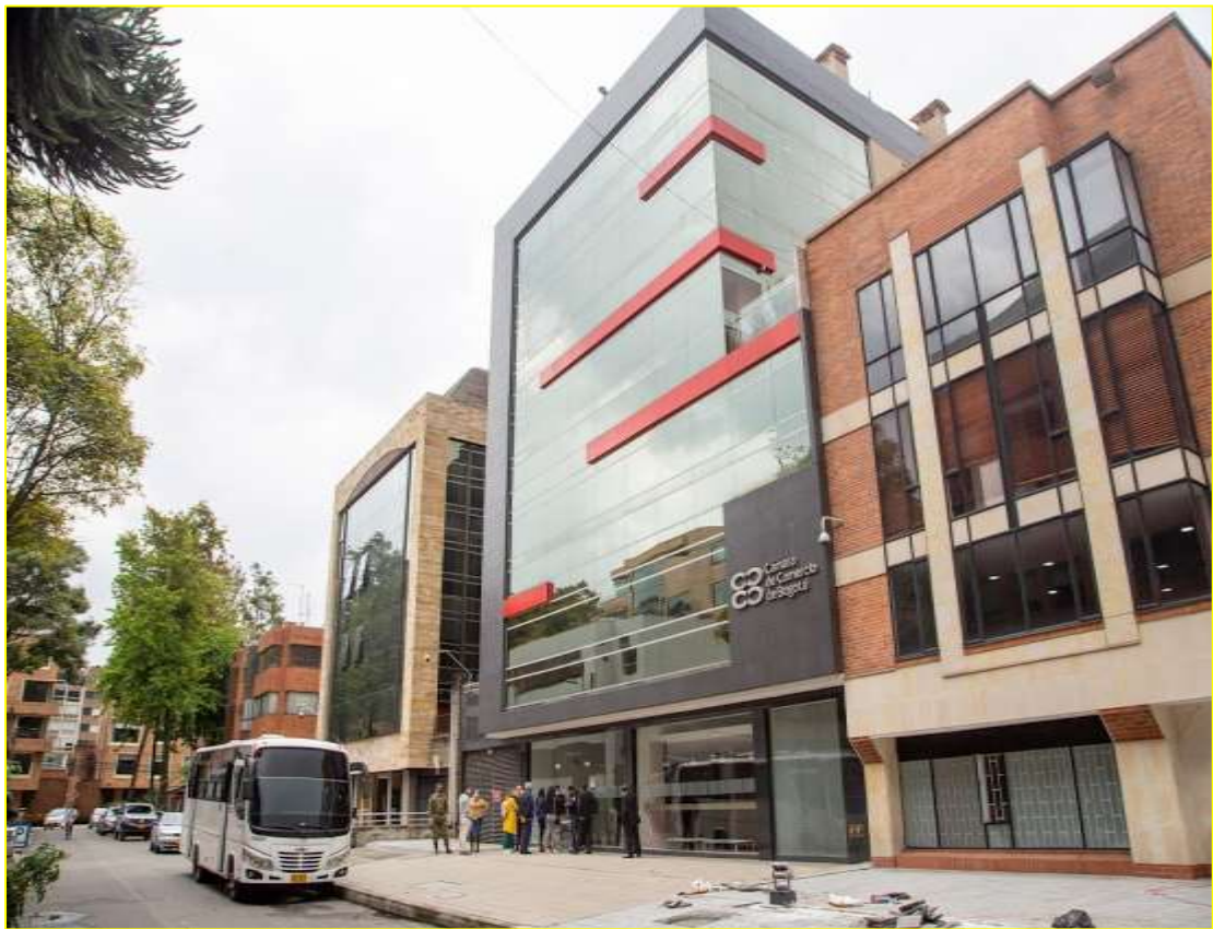
Figura 23. Nueva instalación, Edificio de Posgrados de la Sede Bogotá UMNG
