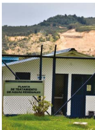
Figura 3.3.6. Planta de Tratamiento de Aguas Residuales
