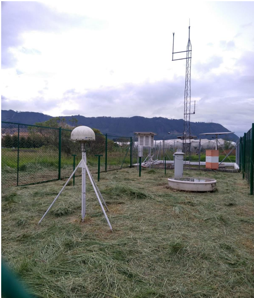
Fuente: División de Infraestructura Estación Geodésica
