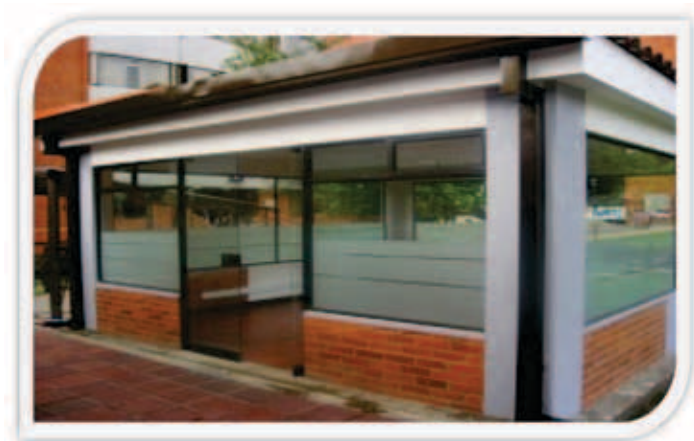
Imagen 61. Adecuación de salas de estudio bloque F
