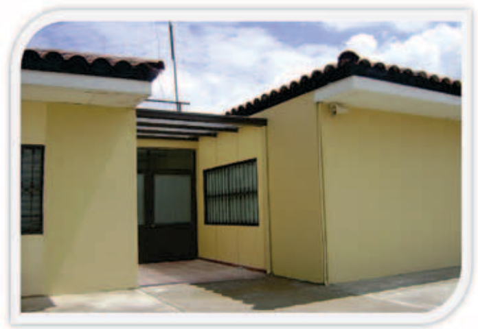
Imagen 56. Adecuación puesto de salud
