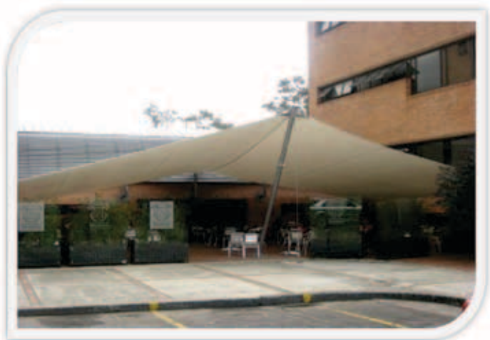
Imagen 64. Suministro e instalación de estructuras en techo - sede Calle 100
