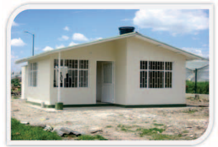
Imagen 77. Construcción de la casa para vigilancia
