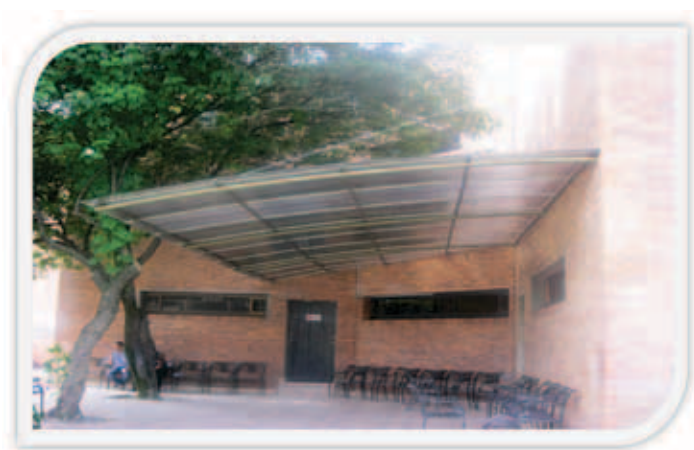
Imagen 62. Adecuación de Plazoleta de Artes
