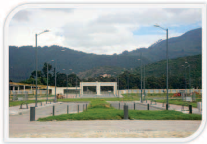
Imagen 54. Vista interna del Campus
