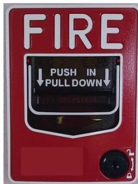
**Figura No. 20. Estación Manual de Alarma**
