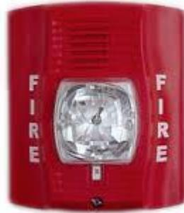
**Figura No. 21. Sirena con luz estroboscópica para interiores**
