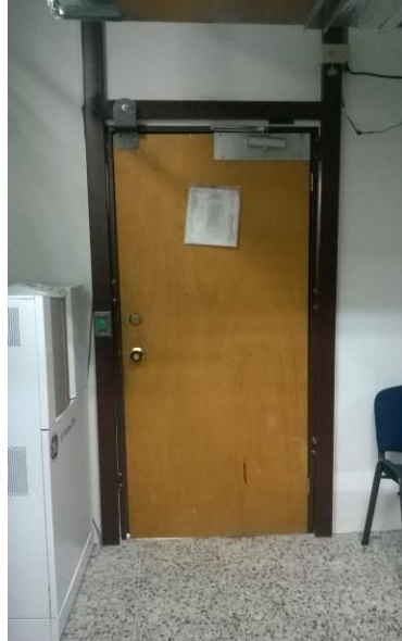
Foto 2: Entrada al Centro de Datos parte interior
