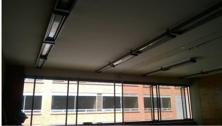
Foto 10: Techo y parte posterior de la nueva ubicación
