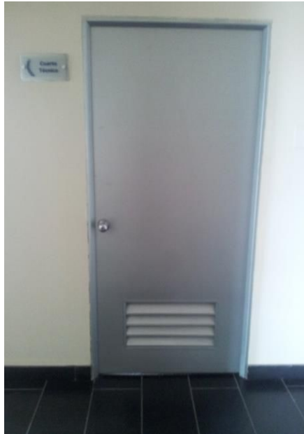
Foto 16: Puerta de Acceso
