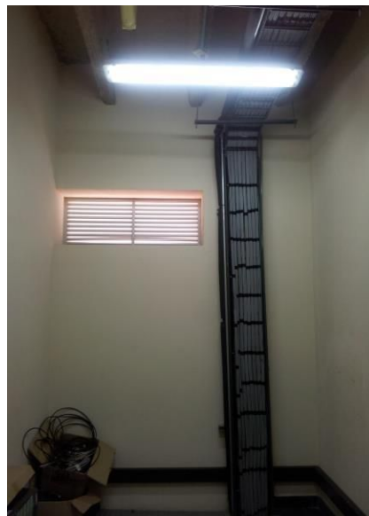
Foto 14: Vista de la Escalerilla
